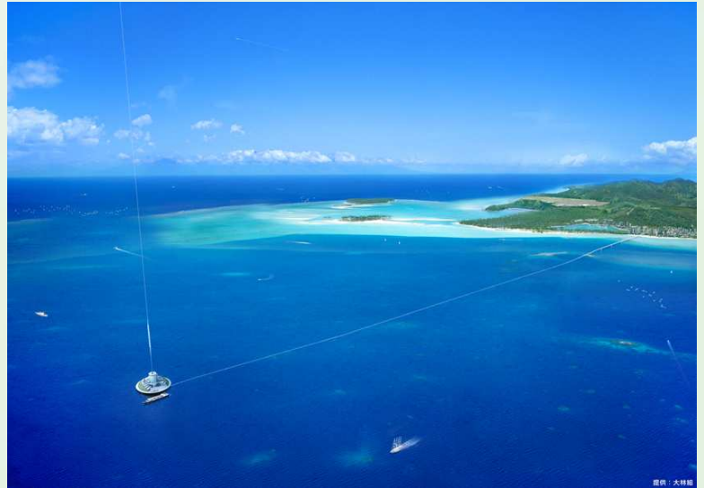
アース・ポート全景(左側が海上の主要施設、右側が陸上のサポート施設)
